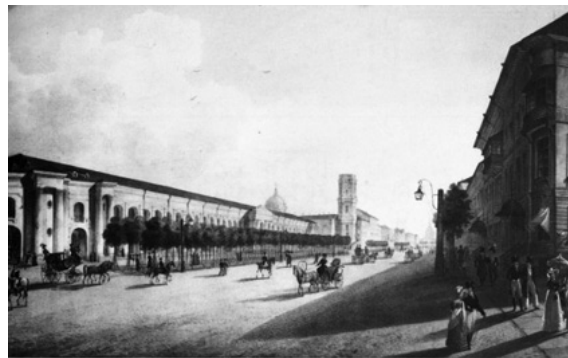
Гостиный двор в Санкт-Петербурге.
